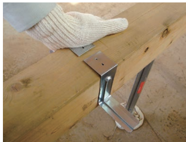
断熱材受け専用金物
