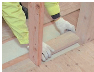
間仕切壁の下部の気流止め
