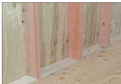
乾燥木材による気流止め
