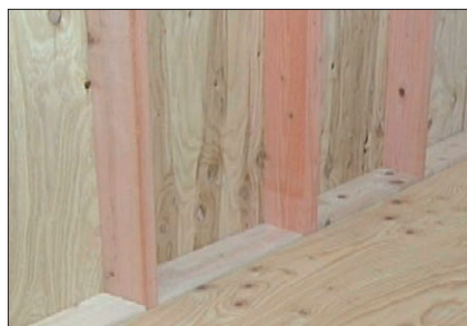
乾燥木材による気流止め
