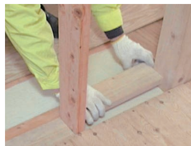
間仕切壁の下部の気流止め
